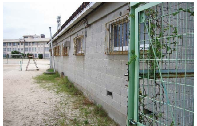
学校内のブロック造構造物（プールと部室）
